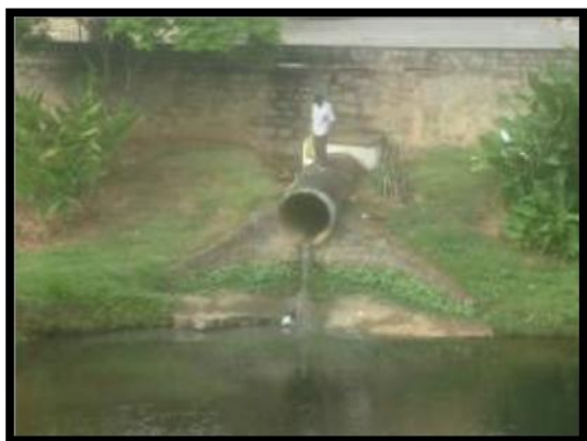
Foto 4: Lançamento de efluentes sanitários na margem direita do rio, à jusante do ponto RCS-JQR- 400 – Rio Jequiriçá. . (Fonte: Programa Monitora, 2010)
